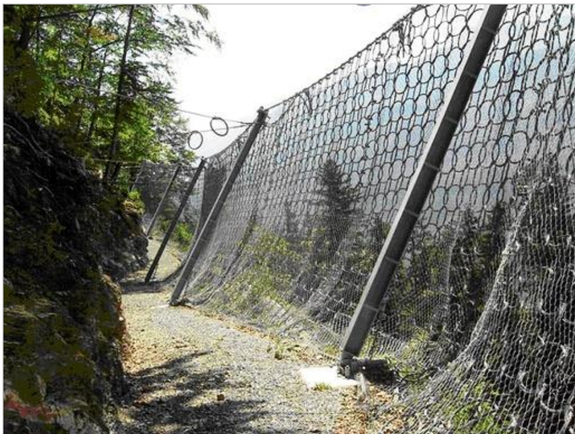
Figure 1: Filet de protection contre les chutes de pierres et son chemin de service
